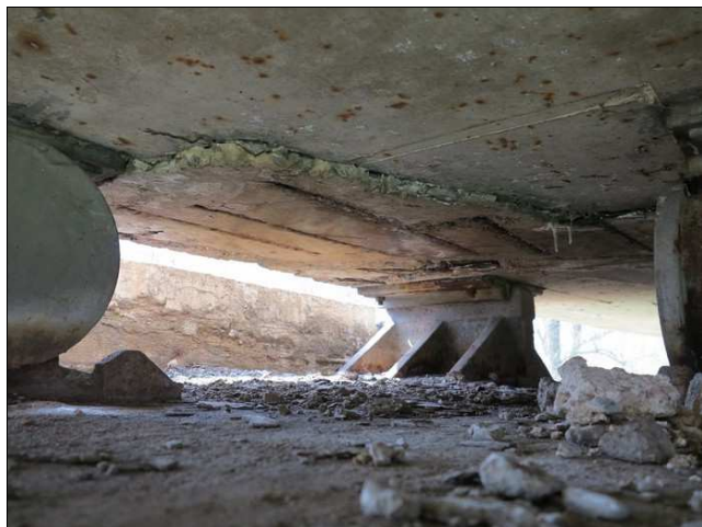
Foto č. 13 – K 04, trhлина a pokles betonu za ložiskem na P 05 vlevo.
