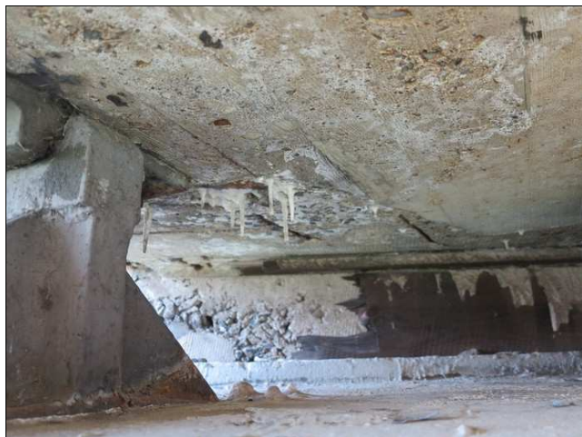
Foto č. 15 – K 05, trhлина, silná degradace betonu a průsaky s krápníky nad O 02.
