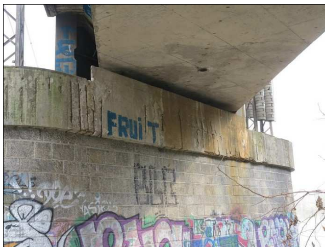
Foto č. 20 – P 01, degradace betonu úložného prahu.
