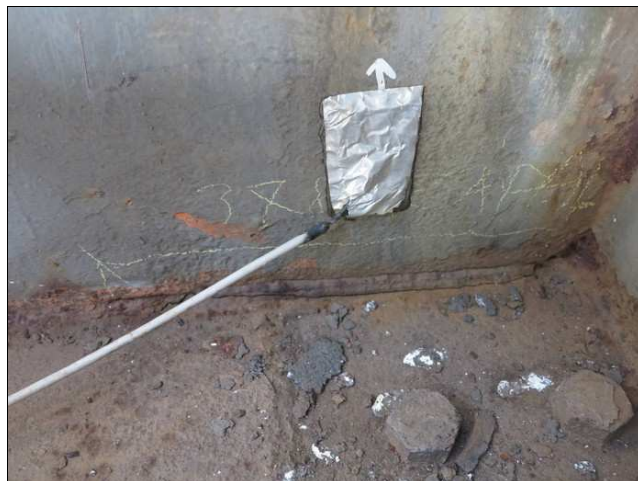
Foto č. 6 – K 02, trhлина mezi dolní přírubou a stojinou u 12. příčníku vlevo
