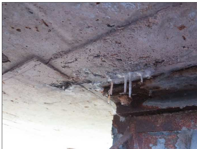
Foto č. 12 – K 03, průsak a degradace betonu v šikmé pracovní spáře z podhledu konstrukce.
