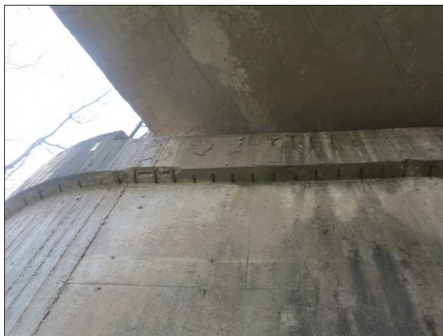
Foto č. 22 – P 05, degradace betonu, nedostatečné krytí výztuže úložného prahu.
