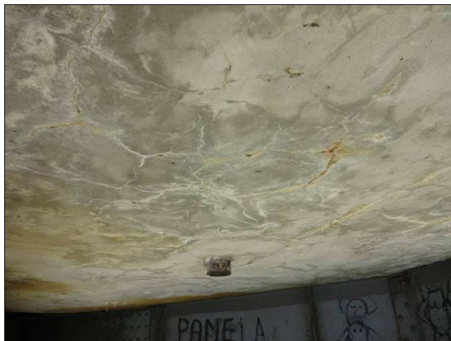
Foto č. 10 – K 02, nepravidelné trhliny s průsaky a výluhy z podhledu desky nad P 04.
