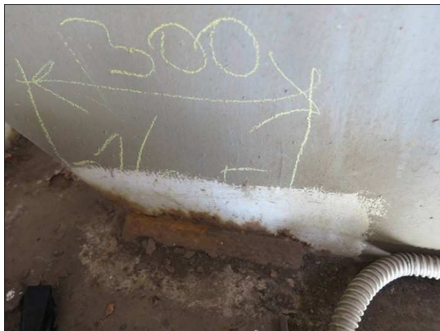
Foto č. 5 – K 02, trhлина v příčníku č. 0 vpravo nad uložením na P 01
