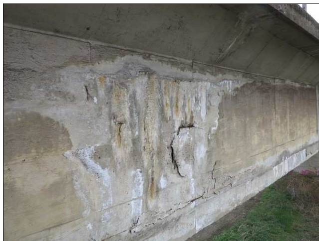
Foto č. 11 – K 03, vpravo z líce nad P 04, průsaky s výluhy, degradace betonu,
