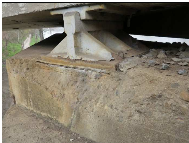
Foto č. 19 – P 01, vylomení úložného bloku vpravo
