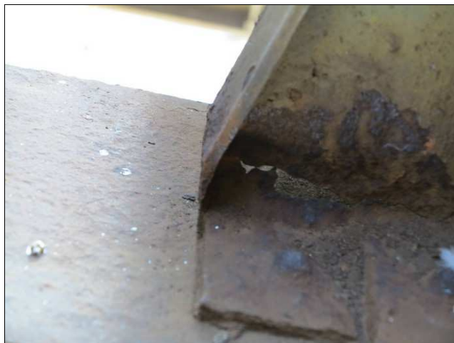
Foto č. 8 – K 02, koroze koutové výztuhy u příčníku č. 45 vlevo
