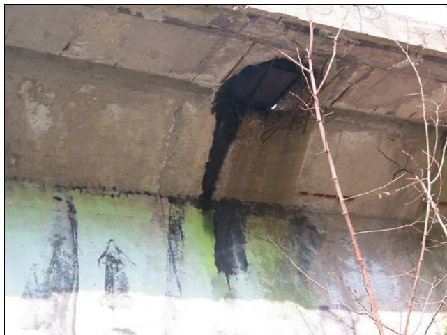
Foto č. 1 – K 01, vysekaný otvor v chodníkové konzoli vpravo.
