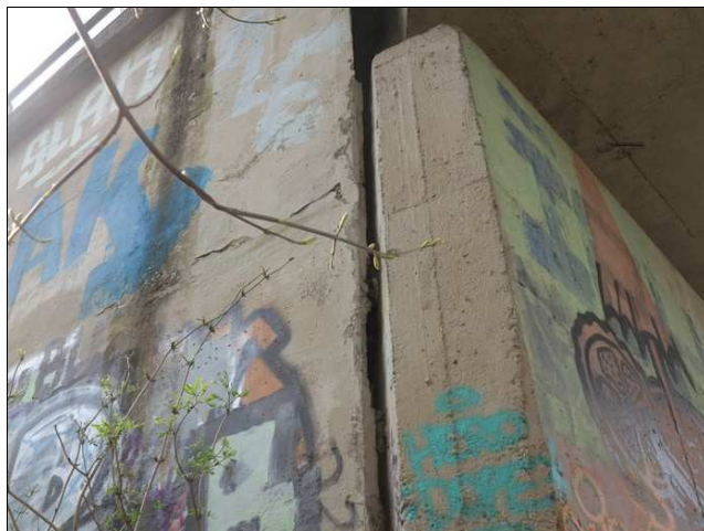
Foto č. 18 – O 01, křídlo vpravo odpojené od opěry.
