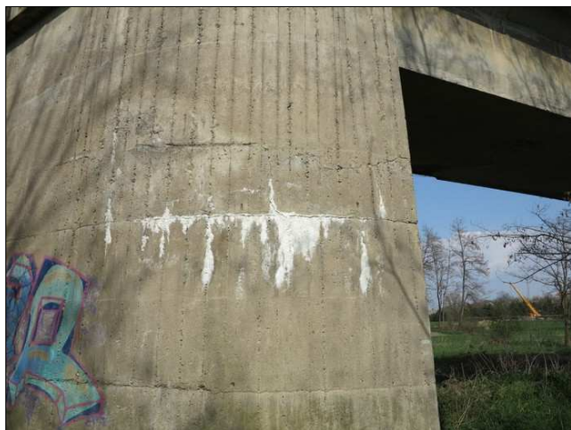
Foto č. 21 – P 05, trhliny s průsaky a výluhy v pracovních spárách
