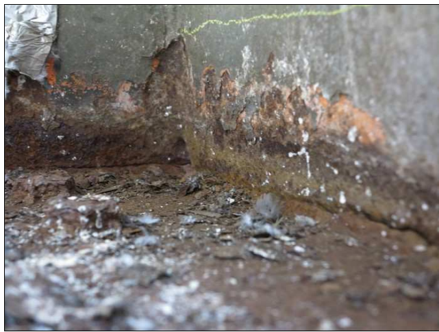
Foto č. 3 – K 02, hlavní nosník vlevo, trhlina u příčnicku č. 12
