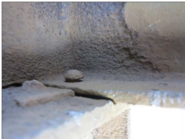
Foto č. 7 – K 02, volný nýt spoj příčník - podélník nad 1. příčníkem vpravo. Koroze stojiny a výztuhy podélníku. Pokles podélníku při průjezdu vlaku.
