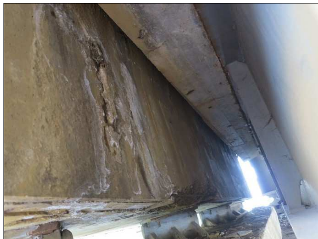
Foto č. 2 – K 01, průsaky s výluhy z čela konstrukce nad P 01
