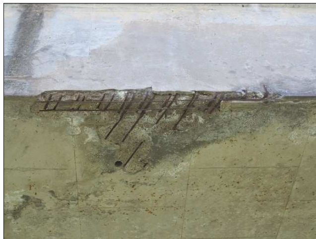
Foto č. 14 – K 04, degradace betonu s odkrytou výztuží u levé dolní hrany.
