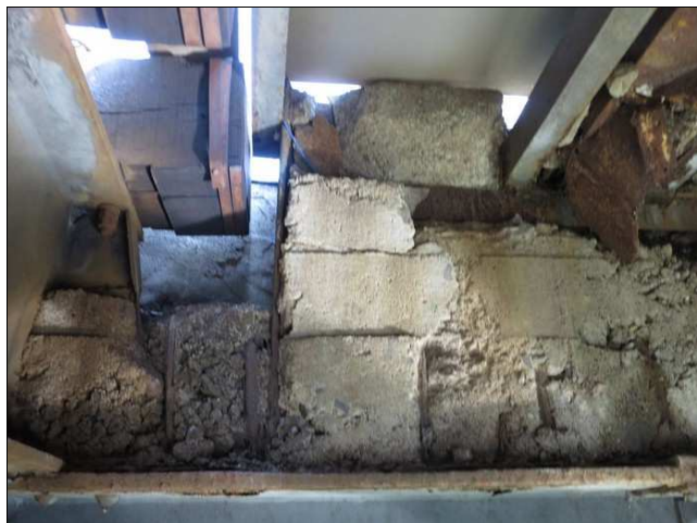
Foto č. 9 – K 02, degradace betonu přechodové desky nad P 04 vlevo.
