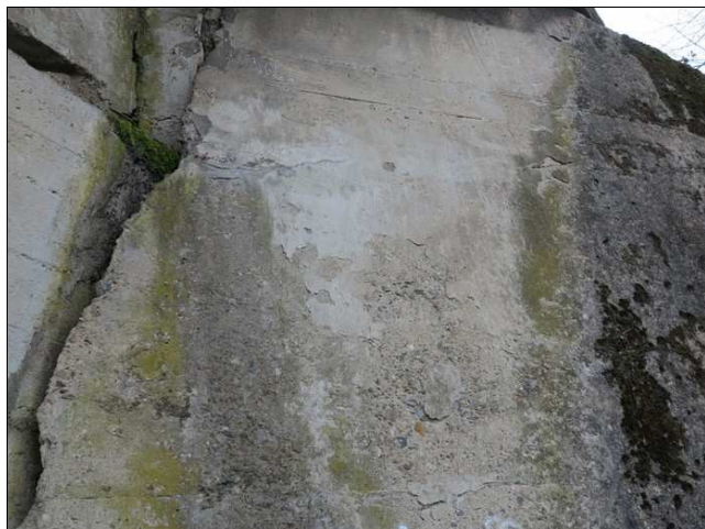
Foto č. 17 – O 01, křídlo vlevo odpojené od opěry a degradace betonu
