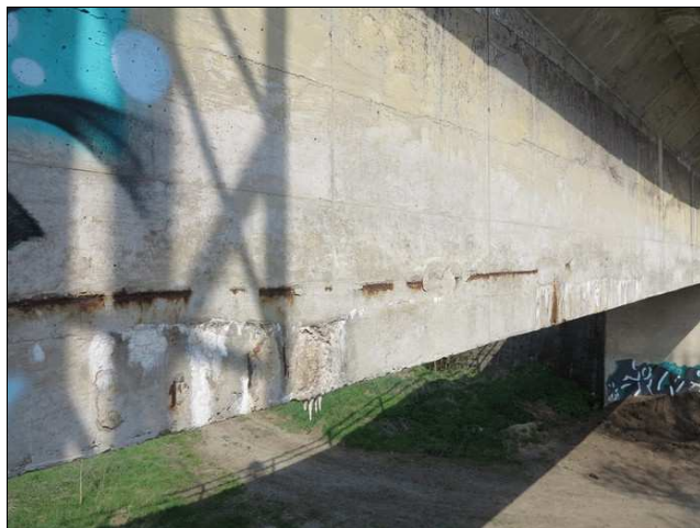
Foto č. 16 – K 05, vpravo z líce nad P 06, trhлина s průsaky a výluhy, obnažení a koroze výztuže
